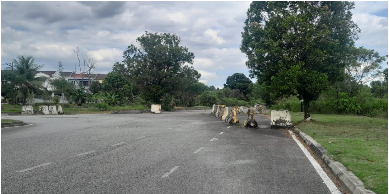
Jalan sedia ada di Persiaran Lestari Putra
